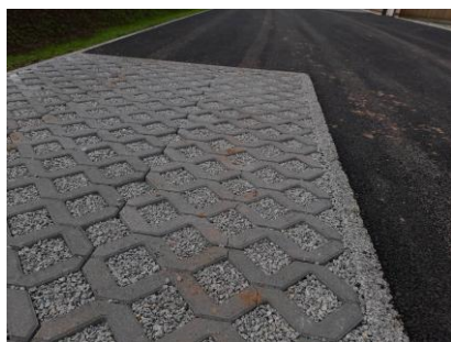
Pavés à joints gravillonnés
