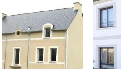
Exemple de modénatures en enduit
