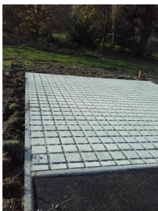
Pavés à joints gravillonnés
